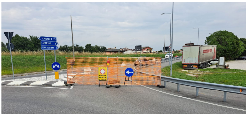
► L'ingresso del cantiere all'incrocio tra la Regionale del Santo e Terraglione
