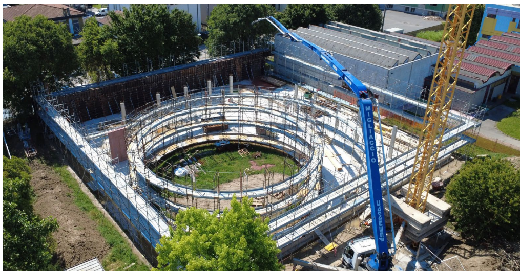
► Foto del cantiere per l'asilo nido gentilmente concesse dalla ditta Radar
