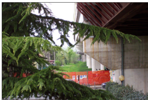
La nuova statale nei pressi di Cadoneghe (particolare)
